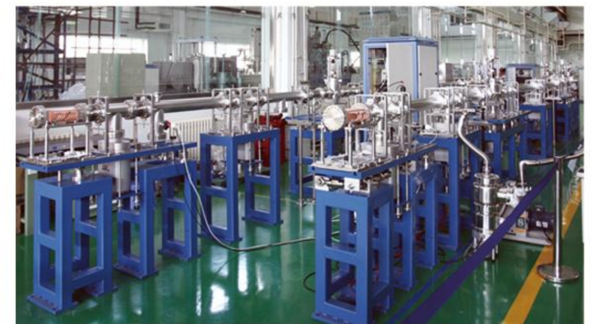
同步辐射-前端区
